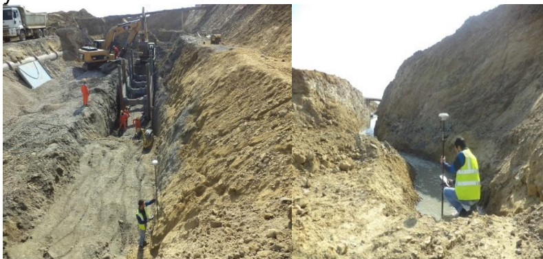
Şəkil 6-7. Su təchizatı qurğularının icra vəziyyətinin yoxlanması.
